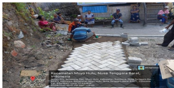
Gambar 2. Pembangunan Paving Gang Desa Sebasang Kecamatan Moyo Hulu Partisipasi dalam pemanfaatan hasil pembangunan
