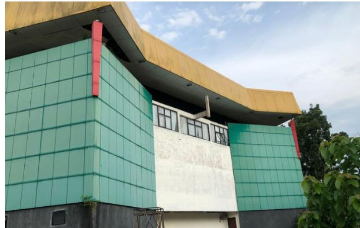
Gambar 3. Fasad Bagian Barat Bangunan
