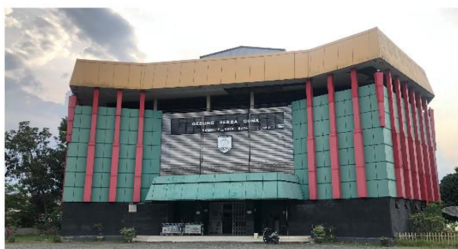
Gambar 2. Fasad Bagian Timur Bangunan
